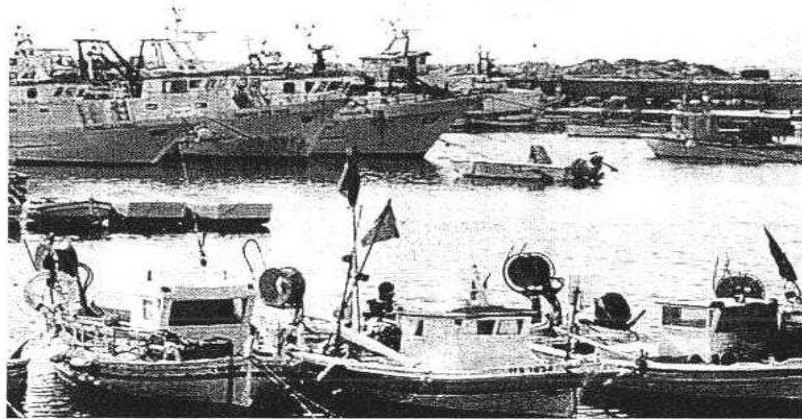
I lavori di manutenzione interesseranno anche il porto di Scoglitti
